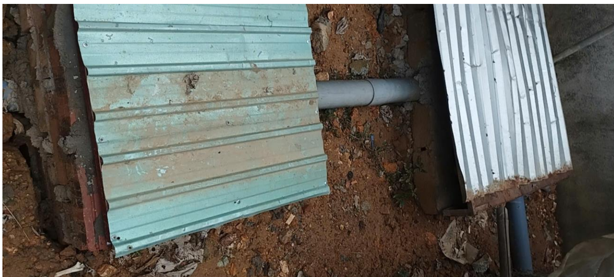
Hình 3. 8. Bể lắng nước thải nhiễm xăng dầu
